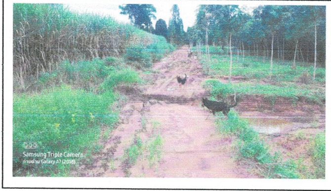
๒๕. ปรับปรุงซ่อมแซมถนนเดิมสายทางบ้านหนองหลวง หมู่ที่ ๕
