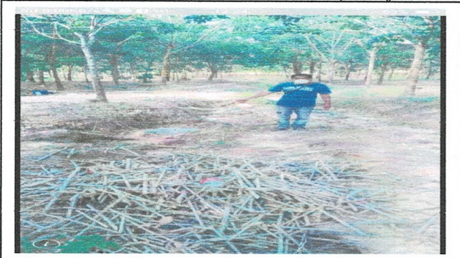
๒๘. ปรับปรุงซ่อมแซมถนนเดิมสายทางบ้านรุน หมู่ที่ ๗
