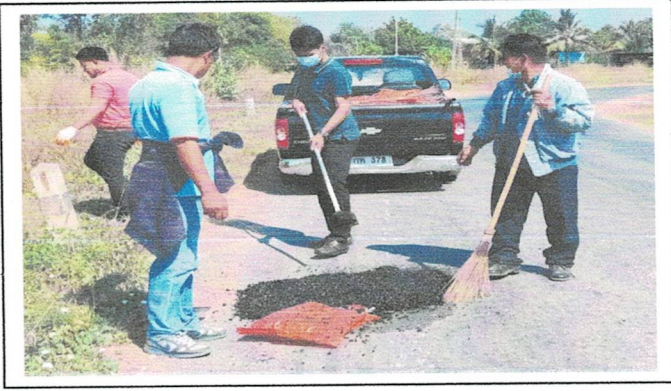
๑๗. ซ่อมแซมถนนภายในพื้นที่ตำบลอาโพน
