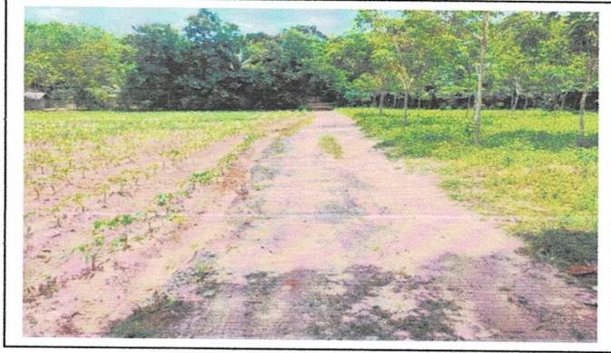
๓๓. ก่อสร้างถนนลาดยางสายอ่างตาดเกิด หมู่ที่ ๑๑ - บ้านสน ตำบลสะเดา
